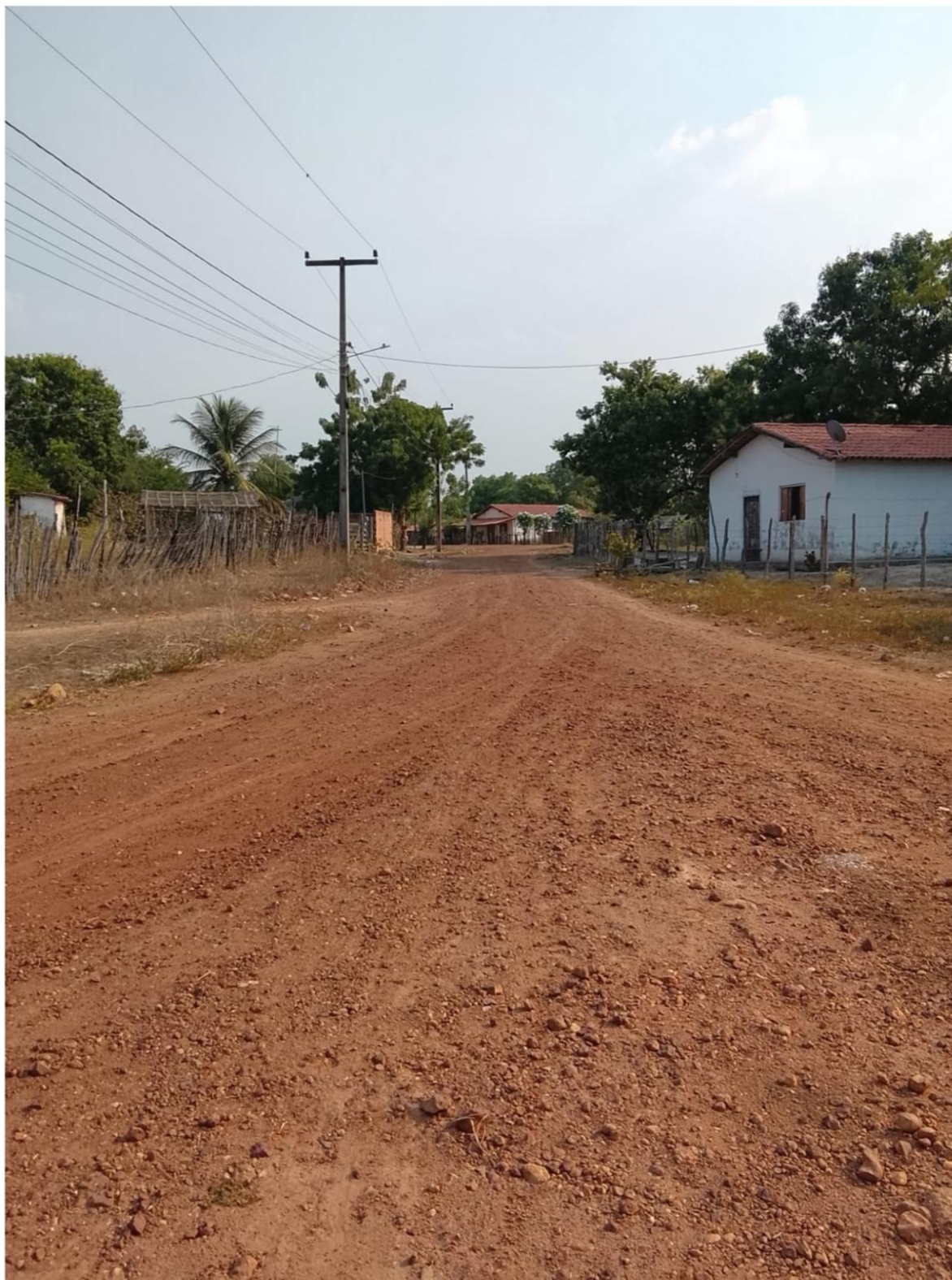
Figura 15 – Rua Vila Nova
