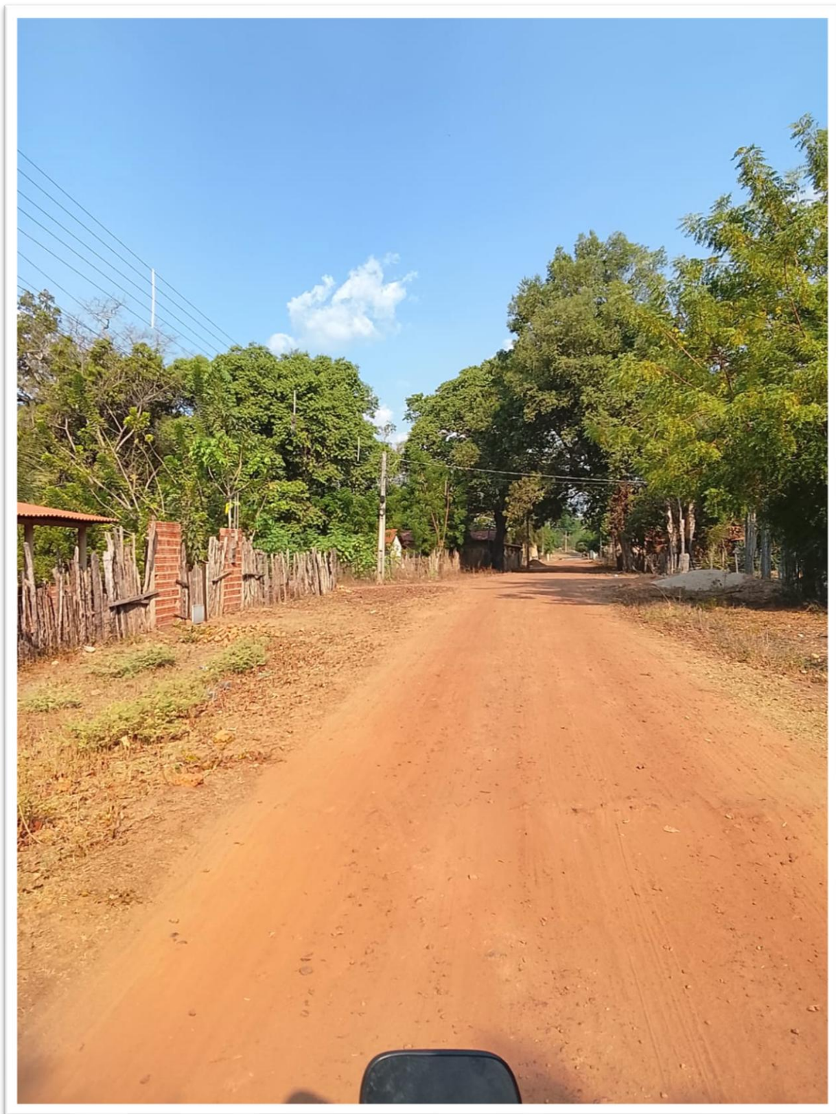
Figura 03 – Avenida São José
